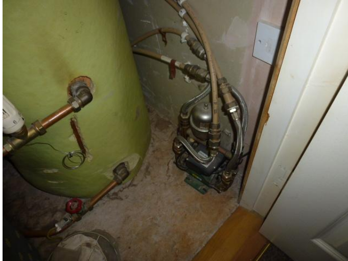
Hot press – pressurisation pump
